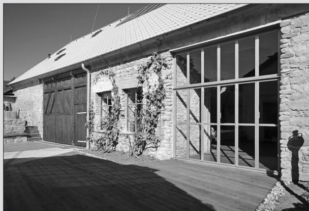
Výstavní prostory galerie vznikly z rekonstruované stodoly
