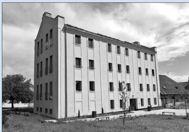
Nově zrekonstruovaná budova ZŠ z bývalého mlýna
