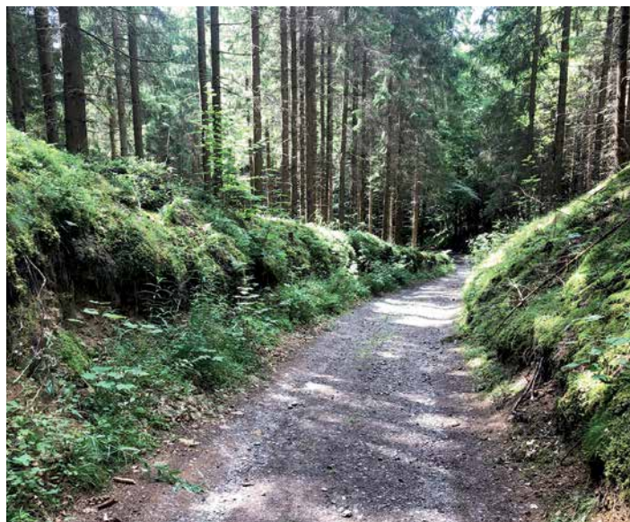
Ukázka štěrkové cesty po 3 letech od dokončení
